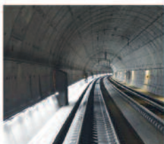
Tunnelsicherheitsbeleuchtung
